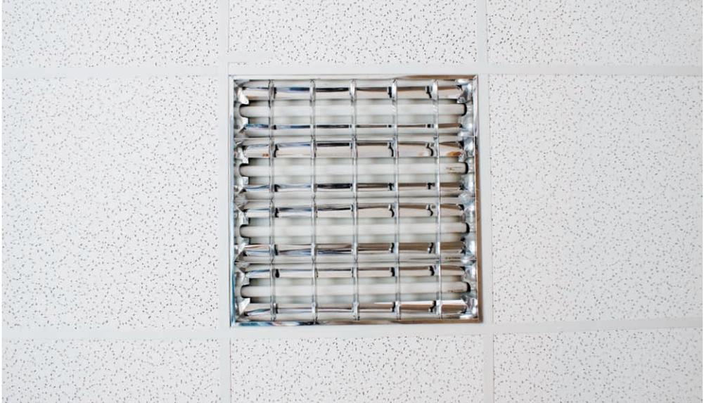
**Рис. 8.12.** Люминесцентный потолочный встраиваемый светильник на 4 лампы по 18 Вт, устанавливается обычно на потолки типа «Армстронг»
