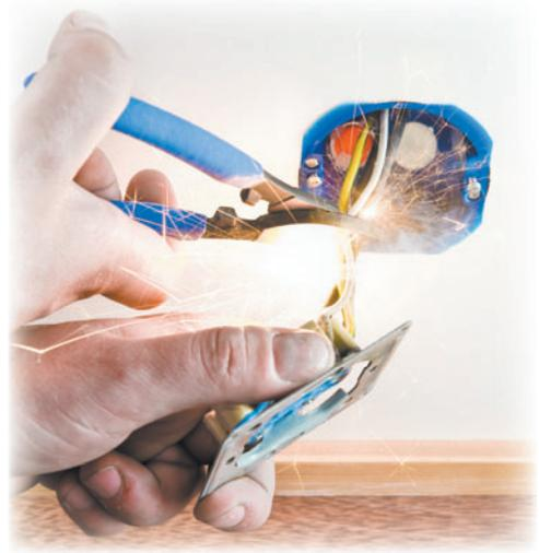
**Рис. 3.14.** Нельзя перекусывать находящиеся под напряжением провода кусачками
