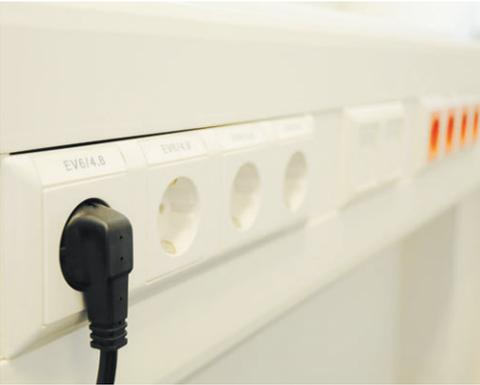
**Рис. 6.57.** Розетки закреплены на поверхности кабель-канала при помощи суппортов
