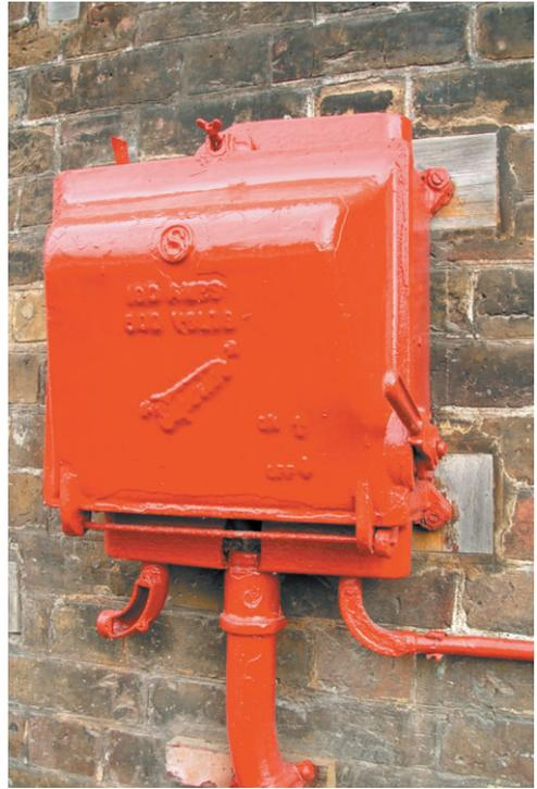
**Рис. 5.112.** Ящик с рубильником, внутри находятся плавкие вставки
