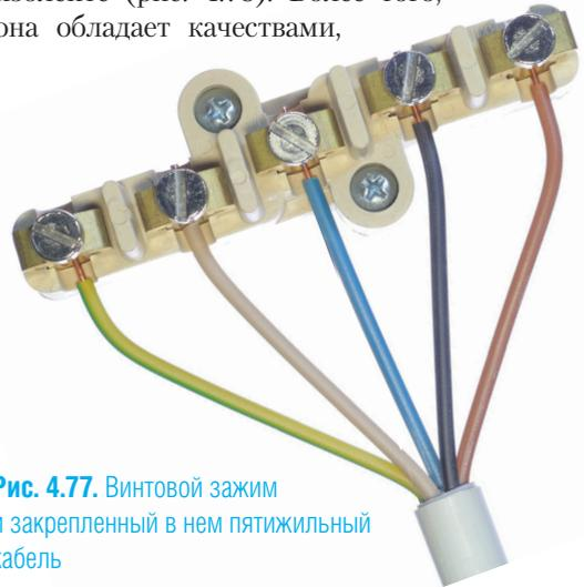
**Рис. 4.77.** Винтовой зажим и закрепленный в нем пятижильный кабель
