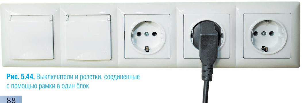
**Рис. 5.44.** Выключатели и розетки, соединенные с помощью рамки в один блок
