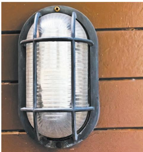
**Рис. 8.17.** Настенный пылевлагозащищенный светильник с решеткой, обычно устанавливается в технических помещениях
