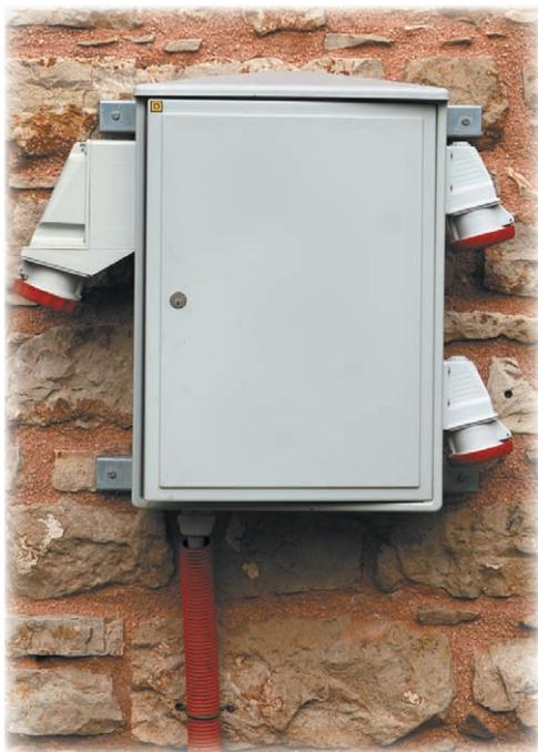
**Рис. 11.39.** Наружный герметичный щит, на корпусе смонтированы силовые разъемы: *слева* — трехфазный, *справа* — однофазные
