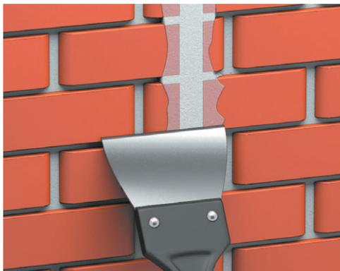
**Рис. 6.32.** Удалите шпателем излишки смеси, выравнивая поверхность
