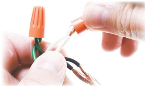
Рис. 4.72. Соединение жил при помощи скруток-колпачков
