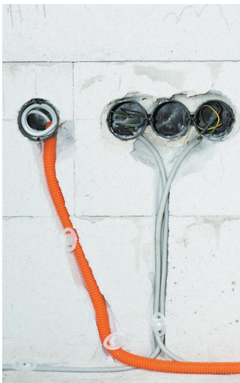
**Рис. 6.33.** Два вида укладки кабеля в стену: в гофрированной пластиковой трубе и без нее
