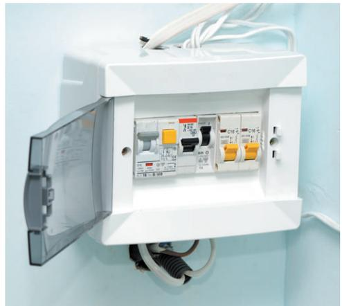
**Рис. 5.113.** Пластиковый бокс наружной установки на 6 групп автоматов
