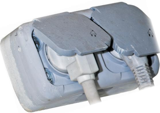
**Рис. 5.47.** Накладная розетка с крышкой для защиты от брызг — такие устанавливают в ванных комнатах
