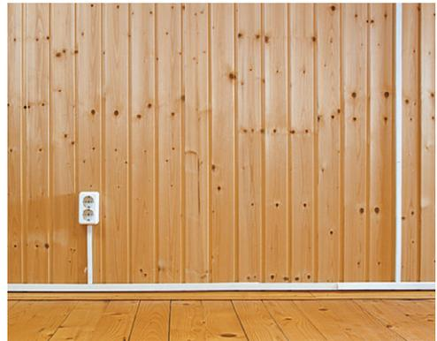
Рис. 5.3. Открытая проводка, уложенная в кабель-канал поверх деревянной облицовки
