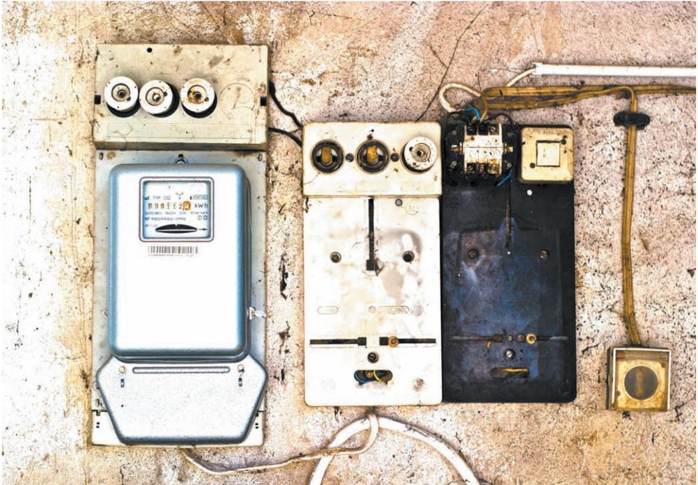
**Рис. 9.2.** Пример устаревшего квартирного щита: механический счетчик, автомат отключения и несколько предохранителей (если у вас в квартире стоит подобный щит, лучше заменить его во избежание аварийных ситуаций)
