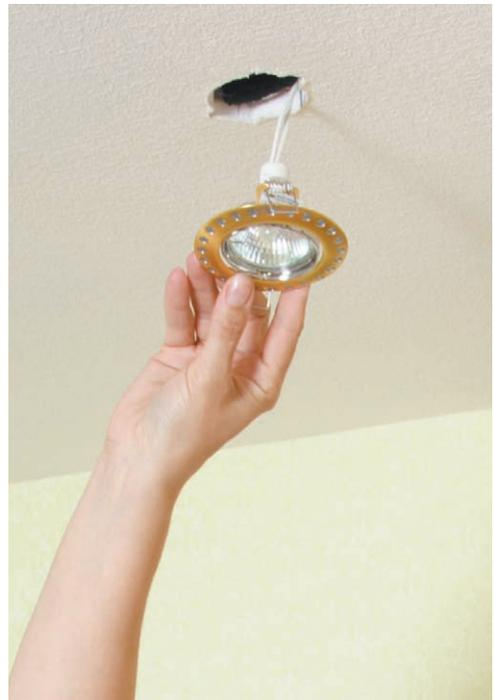
**Рис. 8.32.** Замена точечного светильника
