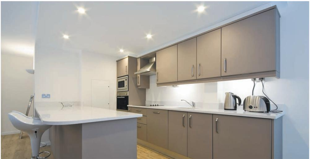
**Рис. 8.54.** Создание зон освещения при помощи встроенных в гипсокартонный потолок светильников с галогенными лампами: видны зоны освещения кухонных шкафов и стойки
