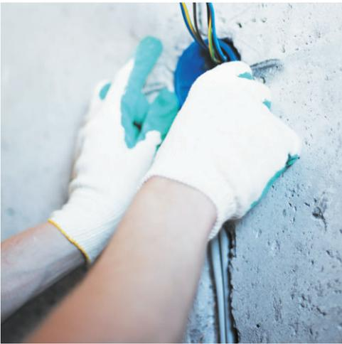
**Рис. 6.22.** Штроба в бетонной стене
