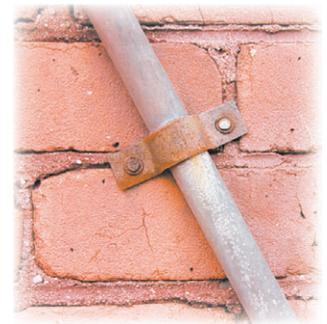
**Рис. 4.59.** Крепление кабеля к стене при помощи металлической скобы
