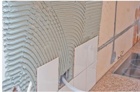
**Рис. 6.24.** После того как проводка уложена в штробу и оштукатурена, можно приступать к другим видам отделки
