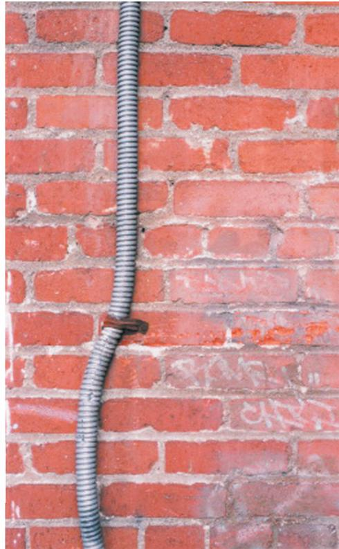
Рис. 5.14. Гофра, проведенная по наружной стене здания
