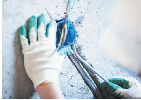
**Рис. 7.15.** Все провода вставляются внутрь коробки, после этого она крепится в отверстии
