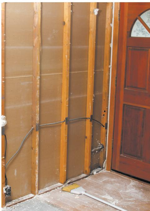
**Рис. 6.45.** Кабель, проведенный за гипсокартонной облицовкой, — нарушение налицо: проводка протянута без защитных пластиковых труб
