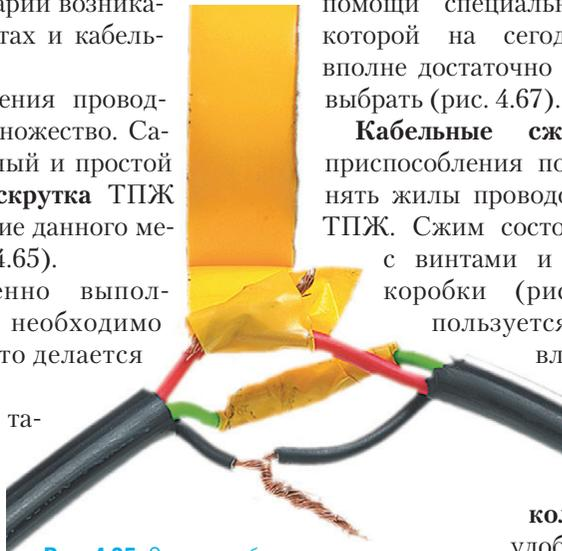
**Рис. 4.65.** Скрутка кабельных жил, сделанная вручную и защищенная изолейтой
