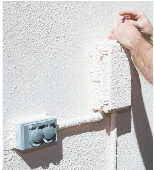
**Рис. 8.46.** Двухгнездовая розетка с крышками и коробка, герметичная крышка которой держится на винтах
