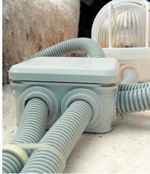
**Рис. 5.29.** Распределительная коробка с гофрой — открытая установка
