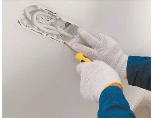
**Рис. 7.29.** Монтаж распределительной коробки в гипсокартонной перегородке
