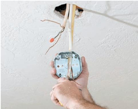
Рис. 8.37. Монтаж коробки крепления под люстру в гипсокартонном потолке
