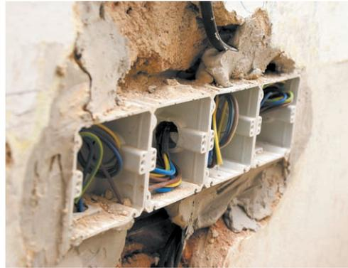
**Рис. 7.16.** Группа установочных коробок, зафиксированных в стене при помощи штукатурки
