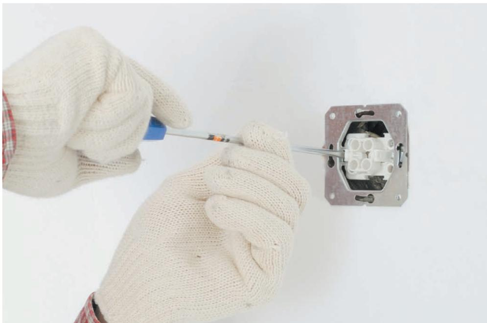
**Рис. 7.31.** Завершающий этап в установке выключателя: колодка прикручивается к установочной коробке шурупами
