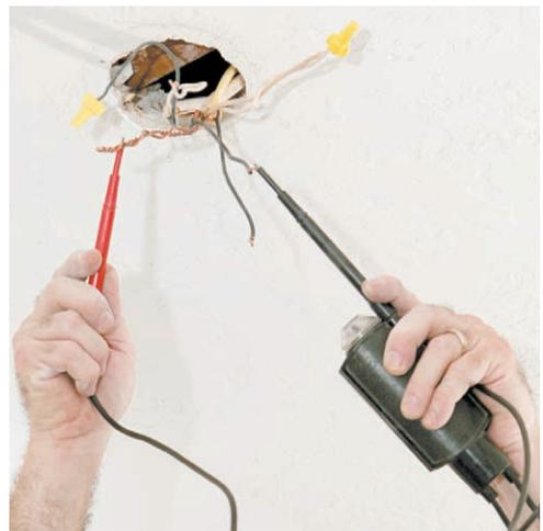
**Рис. 13.2.** Проверка напряжения на питающих проводах светильника
