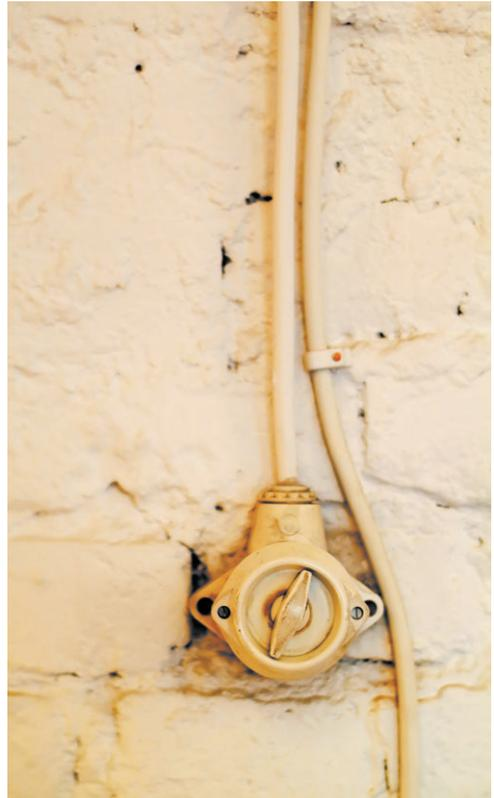
**Рис. 6.49.** Устаревший способ наружной прокладки: кабель прикреплен к стене электроустановочной скобой и ничем не защищен
