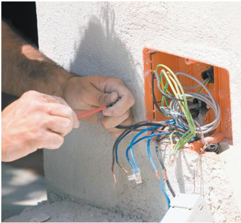
**Рис. 5.24.** Распределительная коробка скрытой установки
