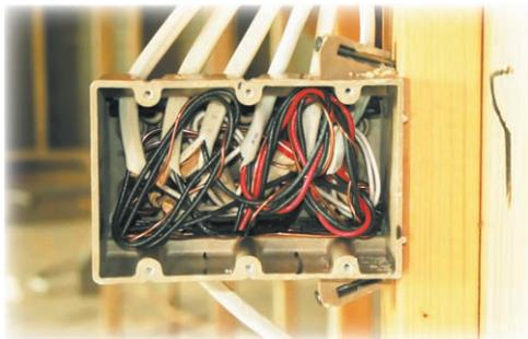
**Рис. 7.23.** Снизу к распределительной коробке подходит питающий кабель, который расщепляется на несколько отходящих проводов
