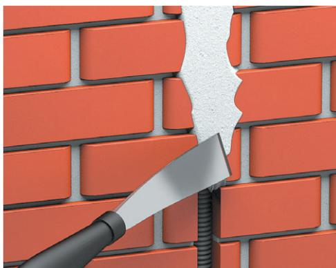
**Рис. 6.30.** Штробу замазывают штукатуркой при помощи шпателя
