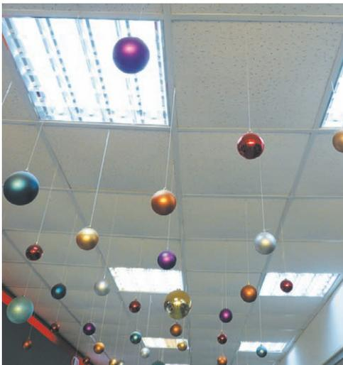
**Рис. 8.34.** Встраиваемые светильники на потолок «Армстронг» — один из самых быстрых и удобных способов монтажа освещения
