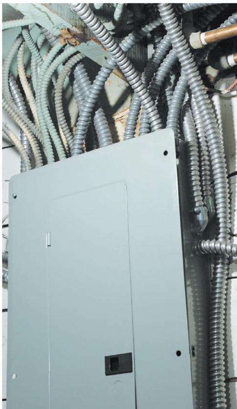
**Рис. 5.16.** Проведение электропроводки при помощи металлорукава в технических помещениях
