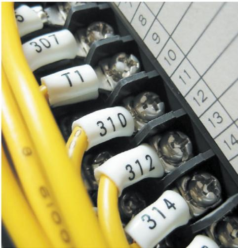
**Рис. 4.61.** Провода присоединены к контактам электроустройства при помощи наконечников
