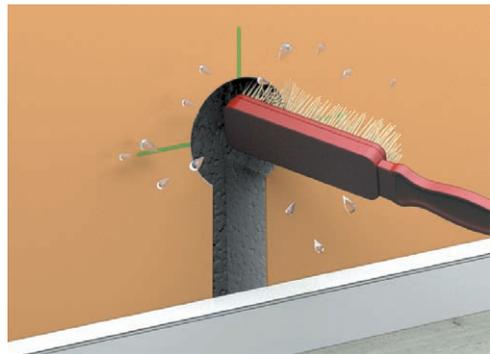
**Рис. 7.8.** Шаг шестой: перед тем как крепить коробку в отверстие, необходимо промыть его от пыли водой и нанести грунтовку
