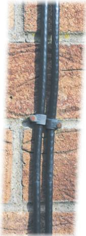
**Рис. 4.56.** Кабель, прикрепленный к стене при помощи электроустановочной скобы
