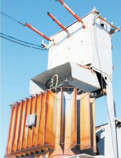
**Рис 1.2.** Трансформатор на подстанции понижает напряжение от высоковольтной линии для передачи в бытовую сеть
