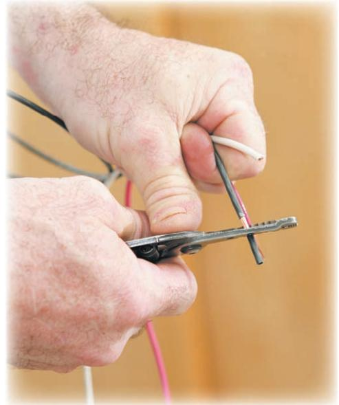
**Рис. 7.18.** Изоляцию с жил удобно снимать при помощи специальных клещей
