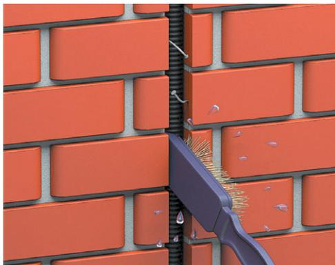
**Рис. 6.29.** Перед тем как замазать штробу штукатуркой, необходимо смочить выемку водой и обработать грунтовкой
