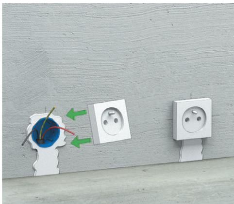
**Рис. 6.44.** Шаг шестой: устанавливаются розетки
