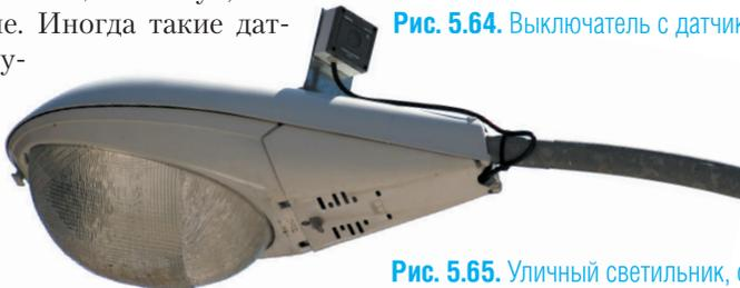
Рис. 5.65. Уличный светильник, оснащенный автоматическим выключателем с фотозлементом
